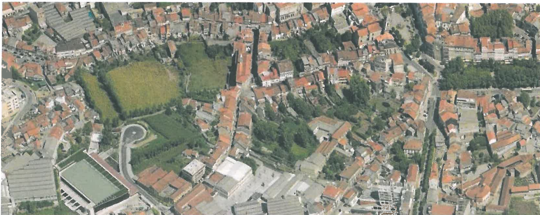
Figura 4 – fotografia aérea da subárea referenciada à rua D. João I, rua de Camões e rua da Caldeiroa
