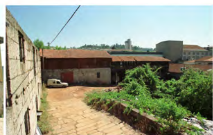
Couros antes obras.jpg
