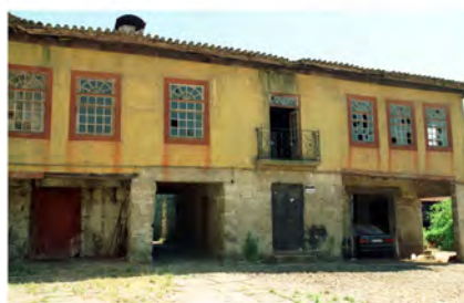
Couros antes obras1.jpg
