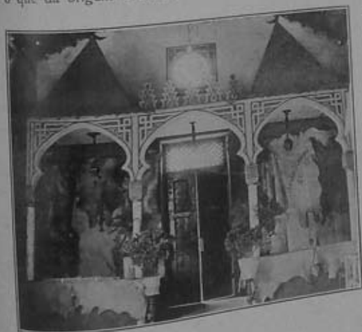
Instalação de F. J. Ribeiro & C.ª, Lda e Souto & Filhos & C.ª
