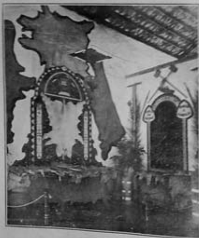
Instalação de Francisco de Sales Guimarães & C a , Limitada
